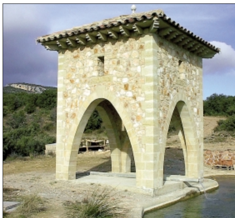
Obra construida en piedra. A.H.
